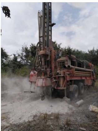
Slaan van de waterput
