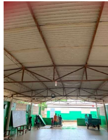
Dak na reparatie
