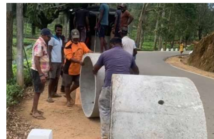
Buizen voor waterputten
