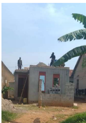
Trainingscentrum in aanbouw
